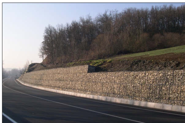
Пример стены из габионов
